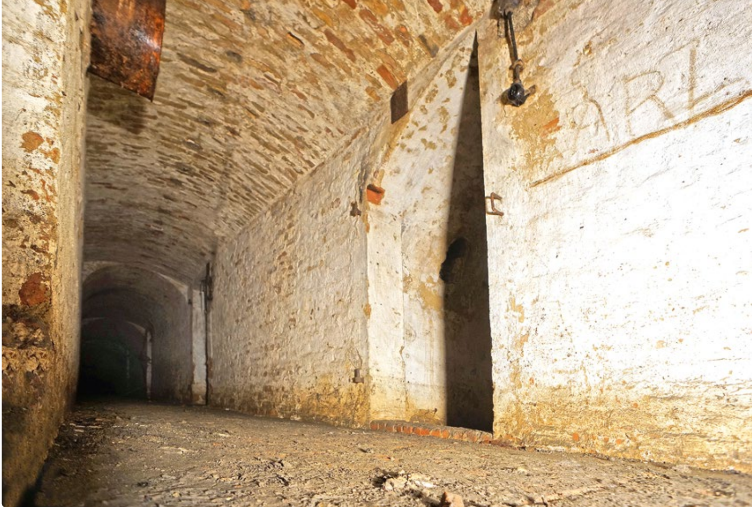
Begehbarer Bunker in der Mühlbastei.
